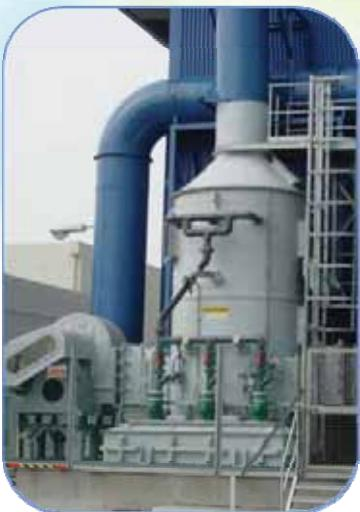
相比于普通的洗涤技术，NOx洗涤则复杂的多。要达到高效的净化效率，需充分了解各个NOx组分之间的相互作用，以及其对排放的影响。维朗帝斯的NOx洗涤塔广泛应用于各个领域。我们可选择合适的设备和化学药品来满足工艺设计要求，确保排气达标。
