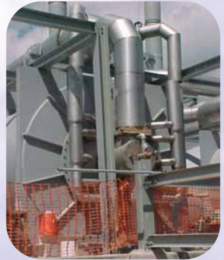
3套 1 亿 BTU/hr 废气废液焚烧炉，废热锅炉， 废气净化设备。
