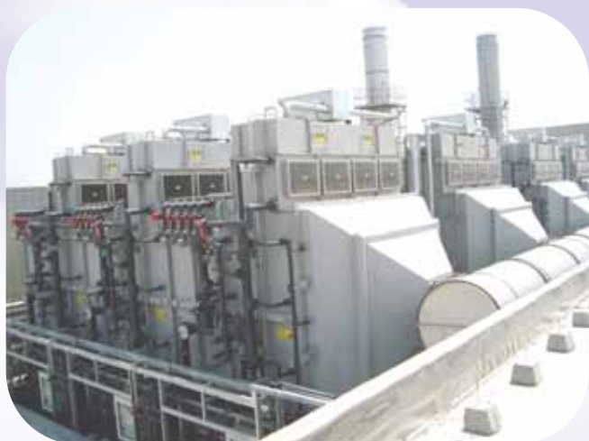
化工废气焚烧尾气处理 3 段式 IWS™ 马来西亚
