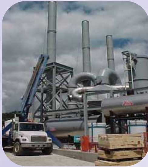
3套 1 亿 BTU/hr 废气废液焚烧炉，废热锅炉， 废气净化设备。
