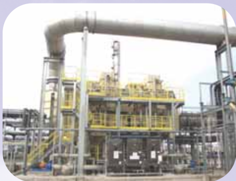
化工废气焚烧尾气处理 3 段式 IWS™ 马来西亚
