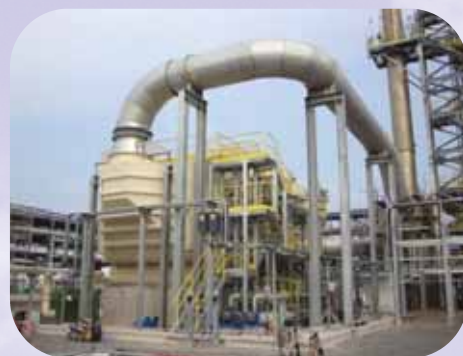
化工废气焚烧尾气处理 3 段式 IWS™ 马来西亚
