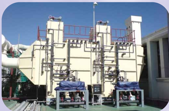
LG Philips 2套2-段式 电离湿式洗涤塔 IWS 450 处理 CVD 废气
