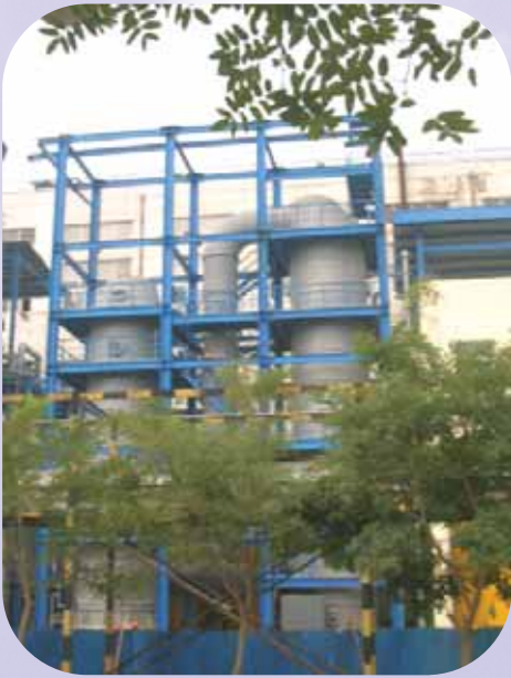
中石油氨气汽提塔/洗涤塔
