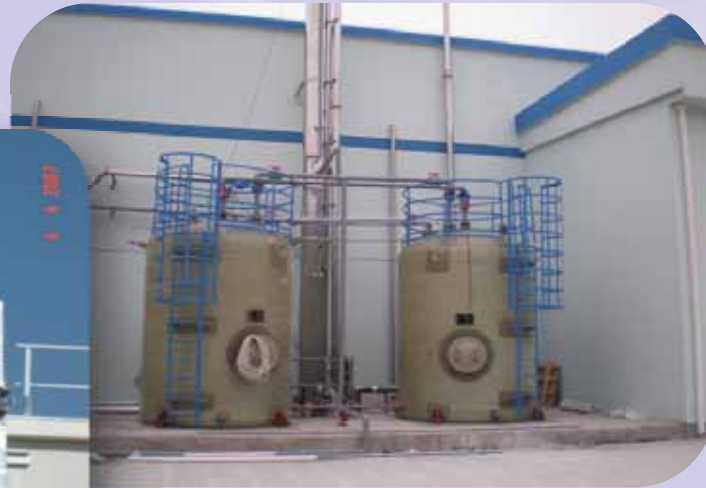
环氧乙烷废气处理系统
