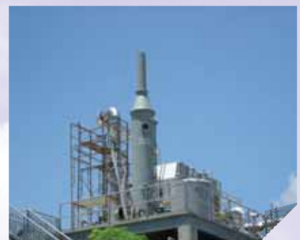
FCI (新加坡) (柔性印刷电路板) 5400 m 3 /h VOC (二 氯甲烷, 甲醇) & HCL (蓄热式焚烧炉和洗 涤塔)
