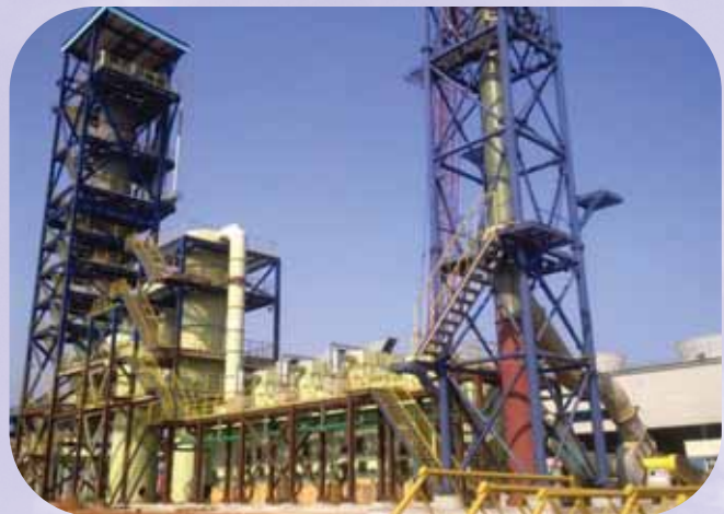
60 GJ/hr 立式焚烧炉（焚烧氯硅烷废气废液），急冷塔，文丘里，IWS 电离湿式洗涤塔 中国江西星火.
