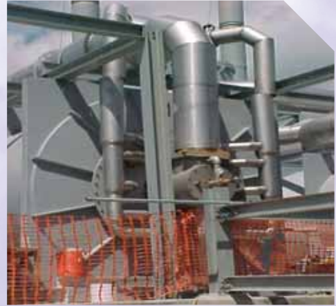
3×30 兆瓦 废液废气焚烧炉 余热回收 尾气净化装置 百时美施贵宝， 美国
